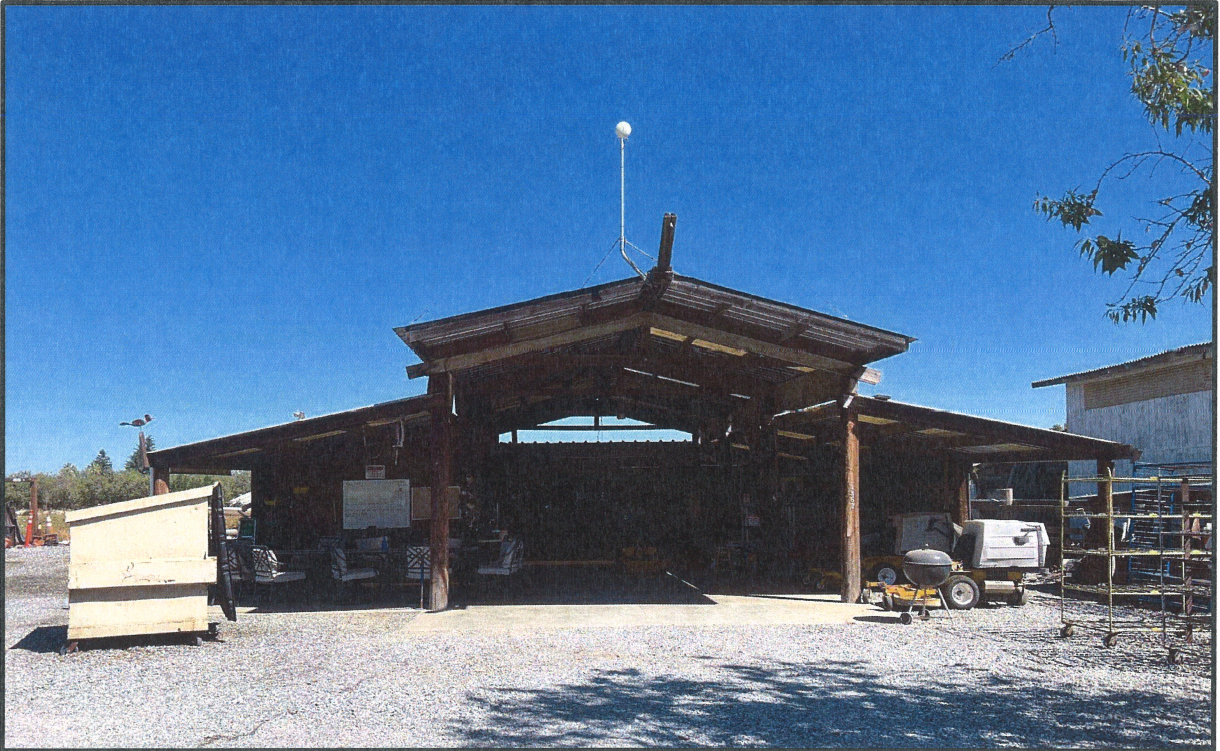
Existing Pole Barn
